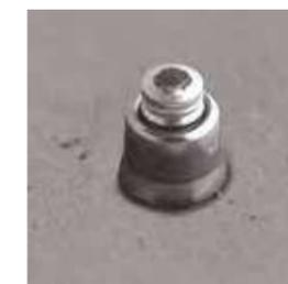
Boulon de structure composé d'une tige et d'une bague. L'outil de pose sertit la bague sur le crantage de la tige. La tige casse au niveau de l'amorce de rupture à la plage de serrage adéquate.
